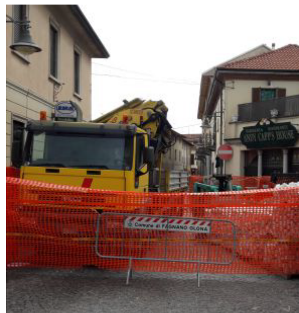
Il cantiere che adesso blocca via Patrioti (foto redazione)
